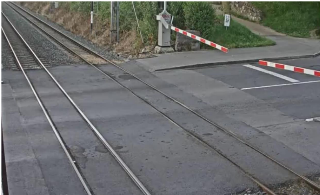
Paso a nivel con 4 semibarreras automáticas
