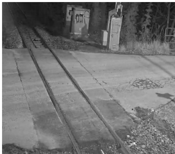
Paso a nivel con iluminación infrarroja
